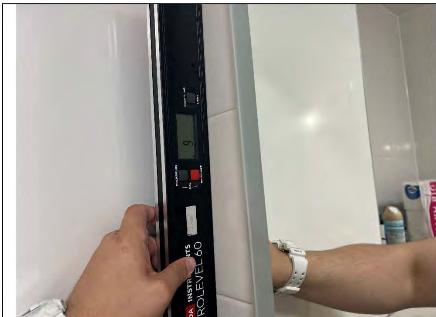
Фото №13. Измерение уровня стен в ванной комнате.
