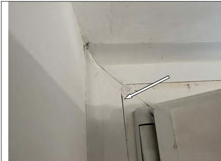
Фото №22. Щель в стыке рамы оконного блока ПВХ и нащельника в кухне.
