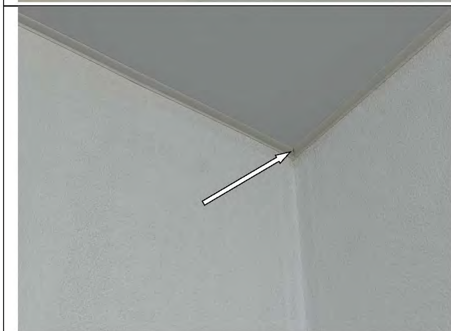
Фото №33. Зазор в стыке декоративного молдинга крепления натяжного потолка в коридоре.
