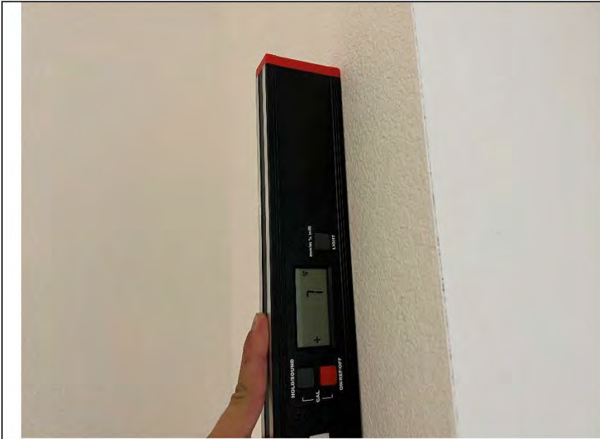
Фото №7. Измерение уровня стен в спальне.
