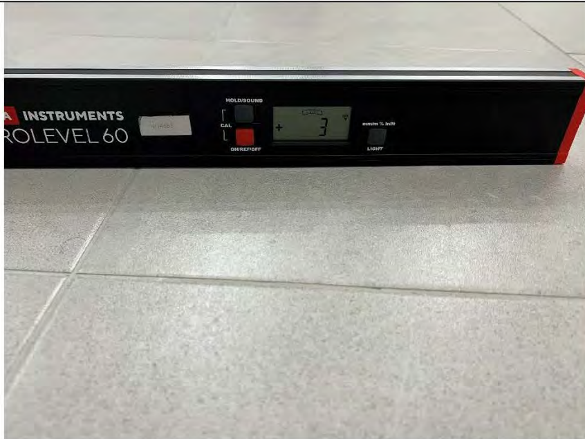
Фото №19. Измерение уровня напольного покрытия в коридоре.
