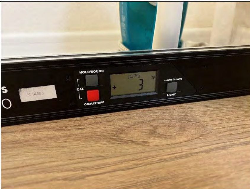
Фото №17. Измерение уровня напольного покрытия в кухне.
