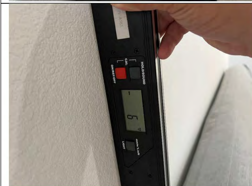
Фото №9. Измерение уровня стен в кухне.
