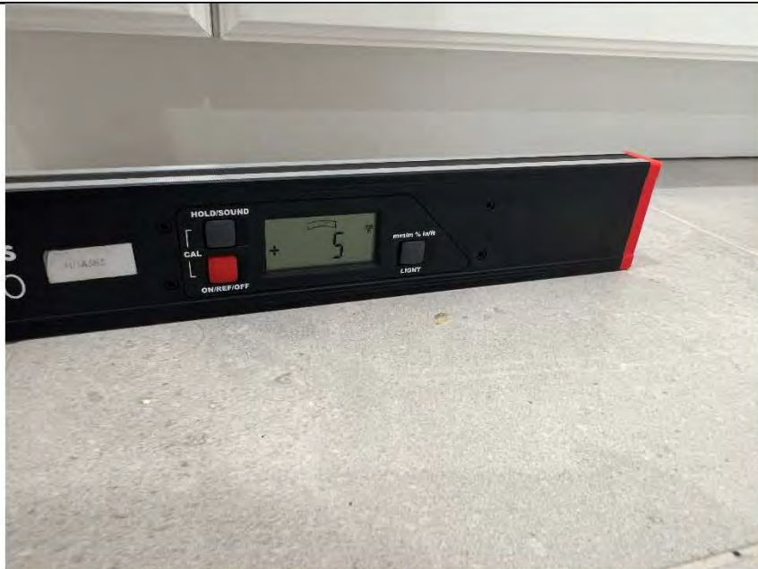
Фото №20. Измерение уровня напольного покрытия в кухне.
